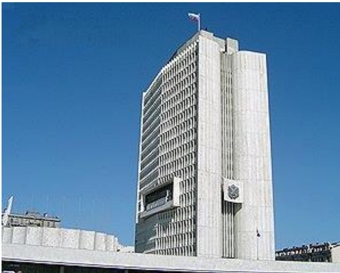
沿海地方行政府庁舎
